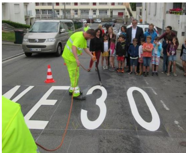
Réalisation du marquage d'une des entrées de la zone par les services de Brest métropole devant une classe d'école
