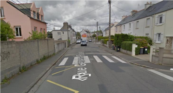
Avant travaux : trottoir côté gauche n'est pas aux normes
