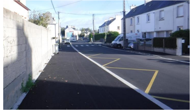
Après travaux : trottoir élargi avec arrêt de bus accessible tout public
