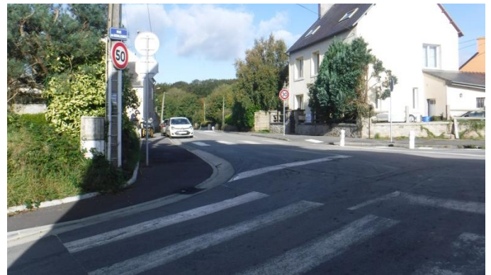
Après travaux (2016) : prolongement du trottoir jusqu'au passage piéton, stationnement sur chaussée pour libérer les trottoirs
