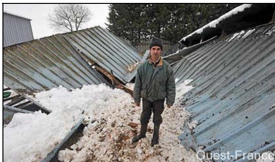
Figure 2.24 : toiture d'un bâtiment agricole effondrée à Lanrodec (source : site internet Ouest-France)
